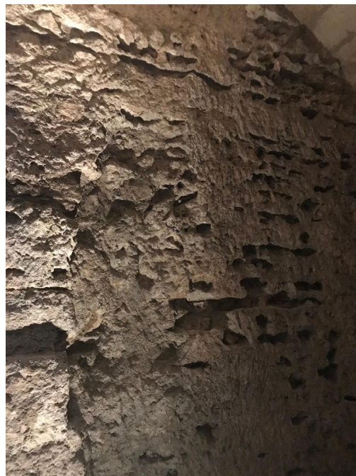
Photo 5 : Mur en calcaire creusé par les latrines.
